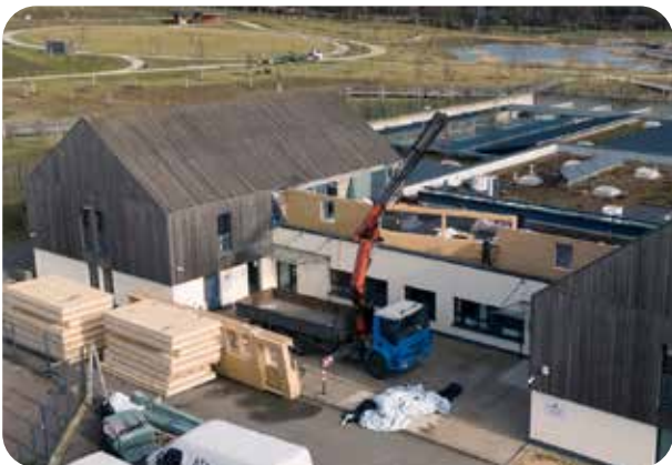
Beginn der Bauarbeiten an der In-house Tierklinik
